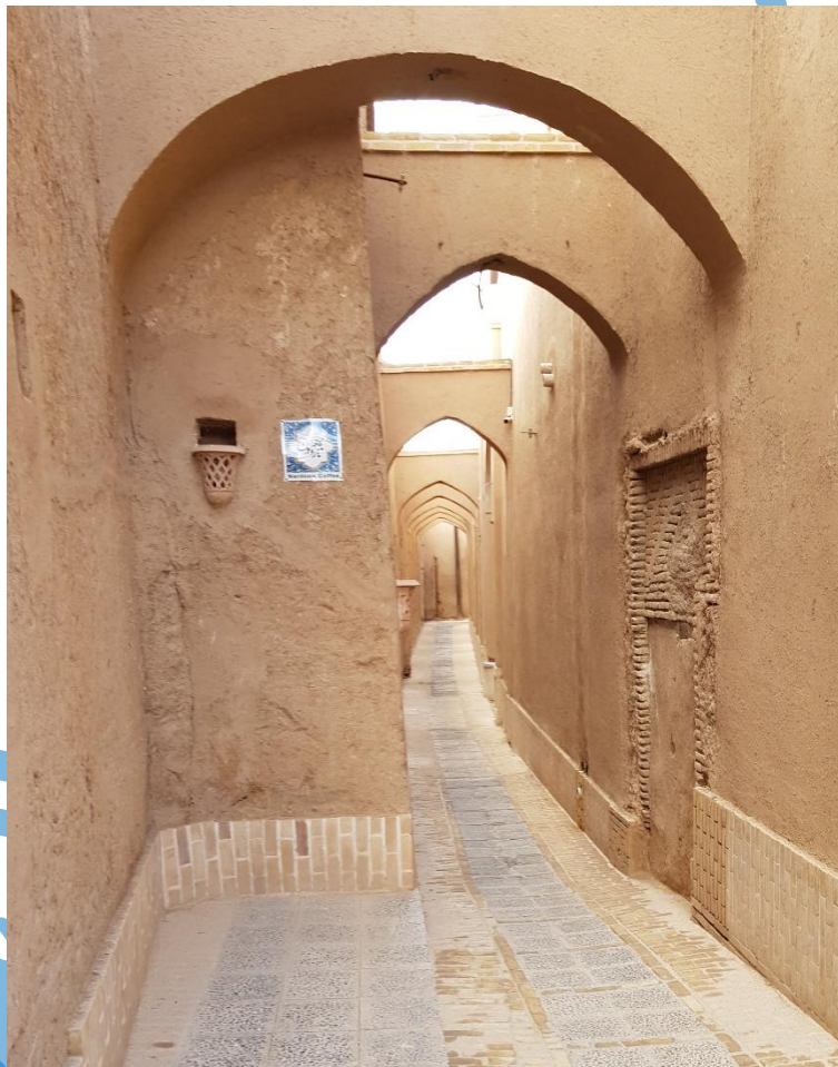
شکل ۲. باریکی معابر و پیوستگی سازه‌ای بناهای بافت تاریخی یزد.
