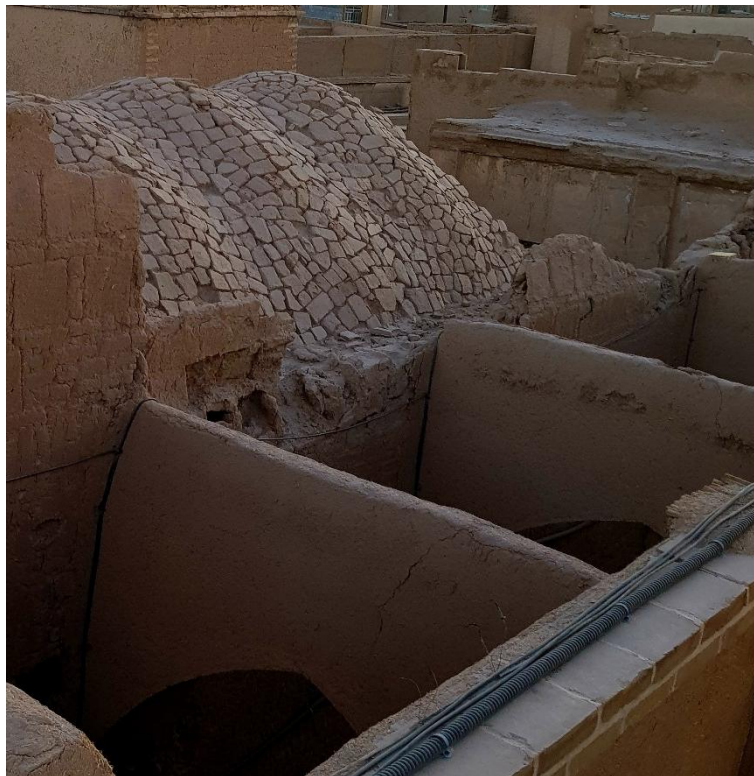
شکل ۳. درهم‌تنیدگی بافت تاریخی و انتقال نیروی رانشی تاق‌ها به وسیله ساباط‌ها.
