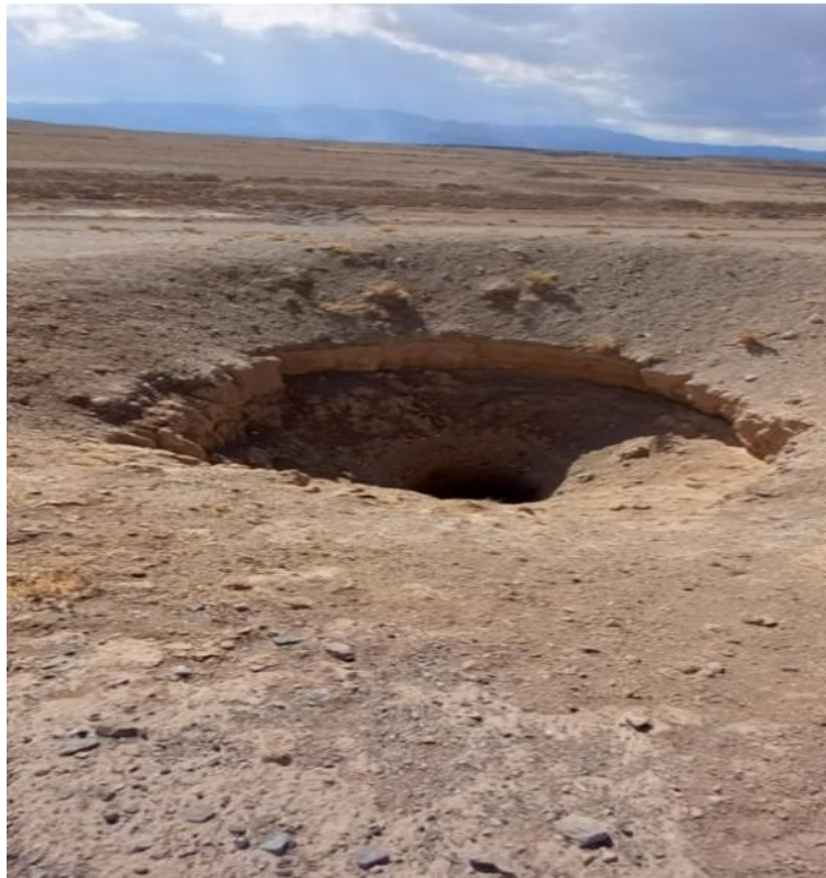
شکل ۱۰. میله چاه قنات قصبه.
