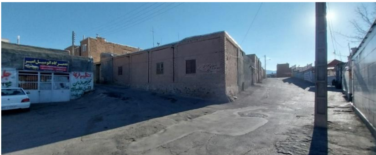
شکل ۱۲. مکان قرار گیری میله چاه کنار تعمیرگاه اتومبیل.
