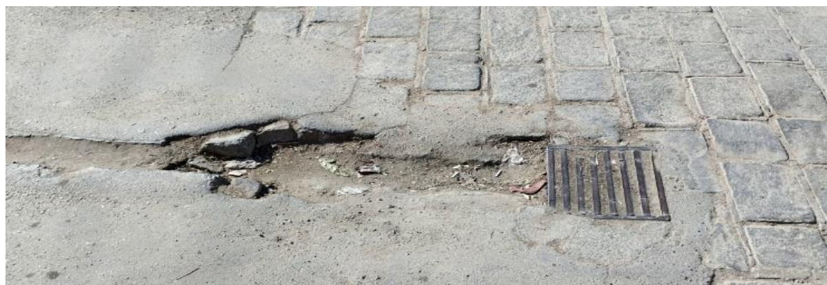
شکل ۱۷. خروج آب از مدرسه شوکتیه.
