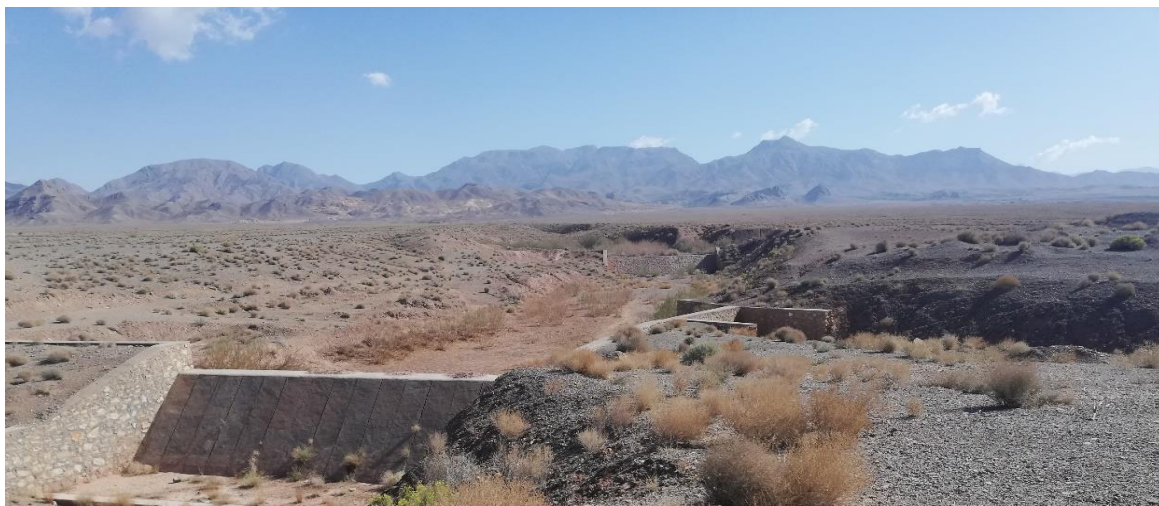
شکل ۱۳. کانال آبگیر منشعب از مسیل اصلی واقع بین دو سرریز.
