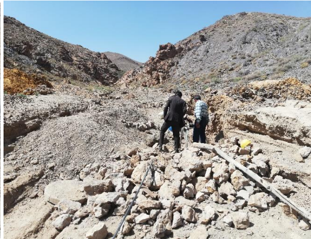
شکل ۶. ریزش برداری از محل ورود سیلاب به داخل قنات خمسیان اشکذر.
