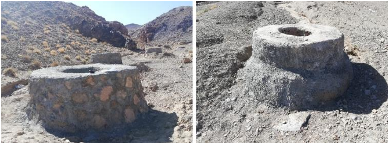
شکل ۱۰. عملیات بهسازی میله هواکش قنات خمسیان اشکذر.
