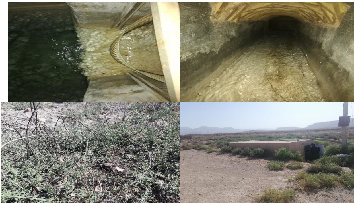
شکل ۴. گیاه خارشتر و توسعه ریشه آن در قنات مزرعه‌نو دهشیر به عنوان عامل کاهش سرعت جریان و تشدید شعه‌گذاری.
