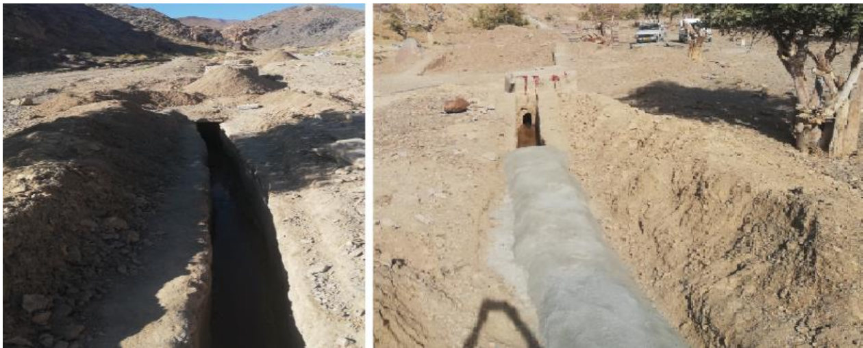
شکل ۱۱. تخلیه و بهسازی هرنج قنات خمسیان اشکذر.
