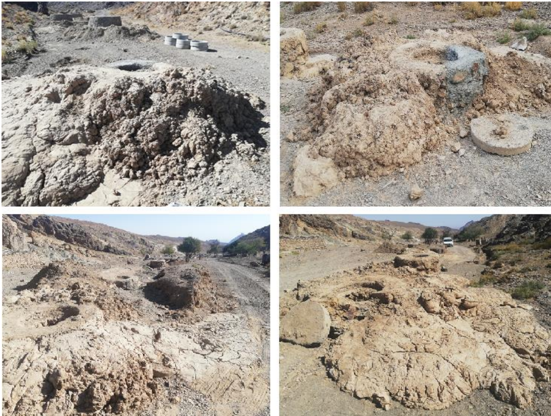
شکل ۷. عملیات لایروبی قنات خمسیان اشکز.
